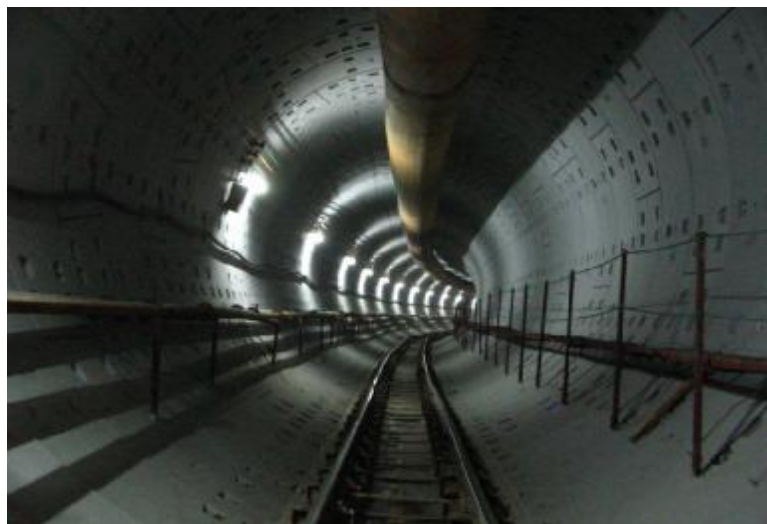
图6 地铁四号线盾构区间
