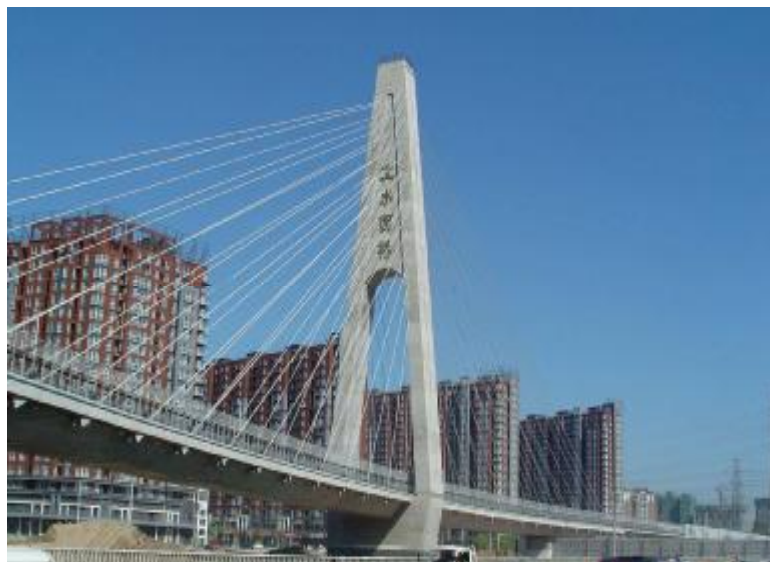
图7 地铁五号线斜拉桥
